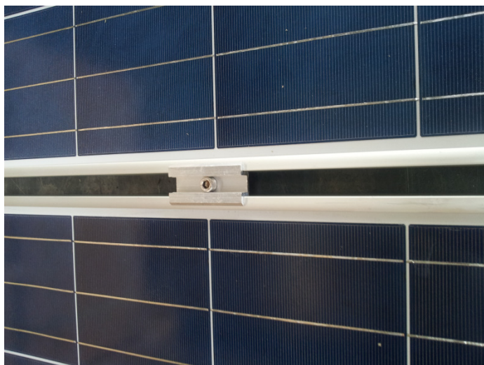
Middenklem montagerail (gemonteerd tussen zonnepanelen)
